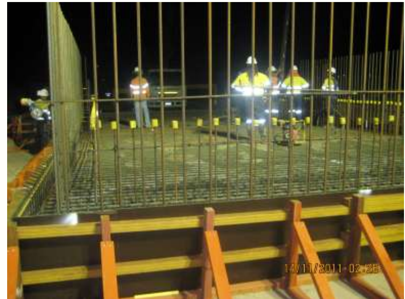
Concrete pour – Primary crusher area
